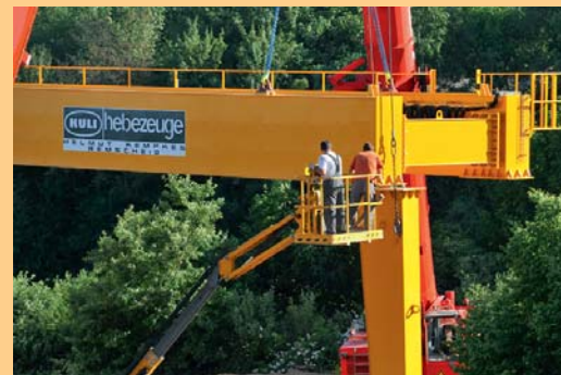
Montage der Feststützen
