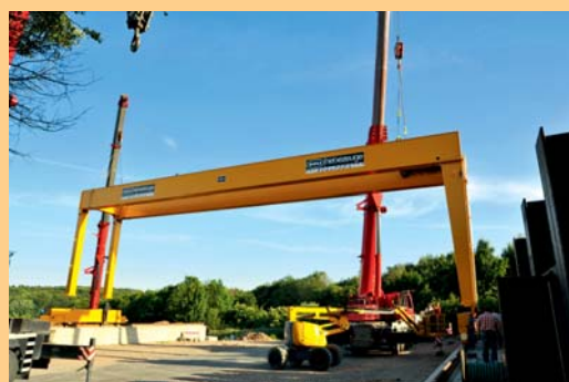
Aufsetzen des Kranes auf die Kopfräger
