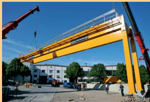
Ziehen des Kranes ohne Feststütze
