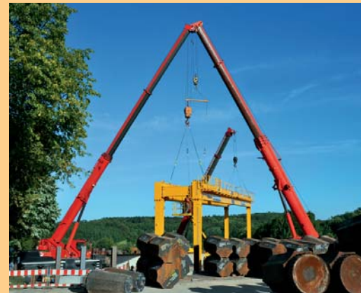
Montage mit Mobilkranen
